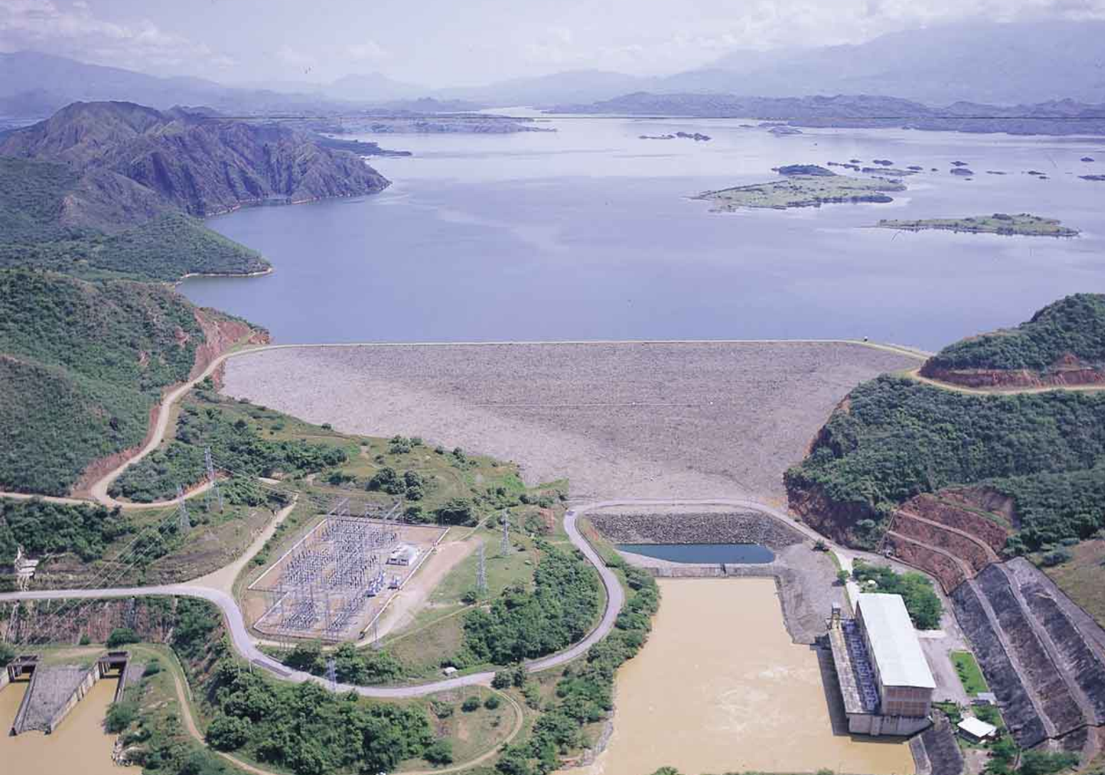
Central Hidroeléctrica Betania, Colombia
