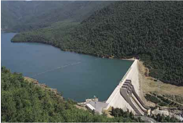
Central Hidroeléctrica Pangue, Chile
